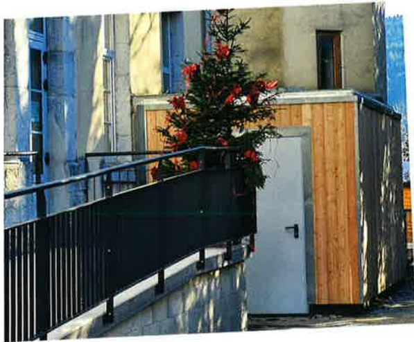
Nouveaux accès PMR
