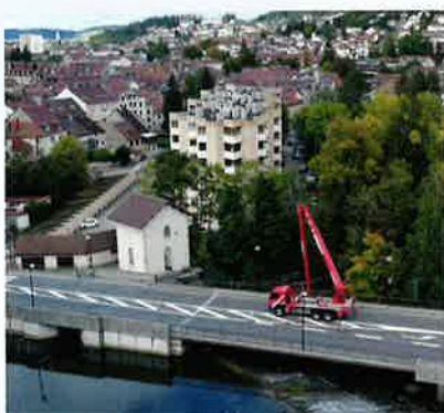
Des nacelles négatives ont permis de fixer des supports sous le pont pour passer les canalisations.
