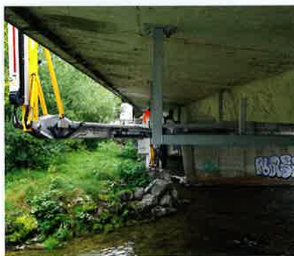
Des nacelles négatives ont permis de fixer des supports sous le pont pour passer les canalisations.
